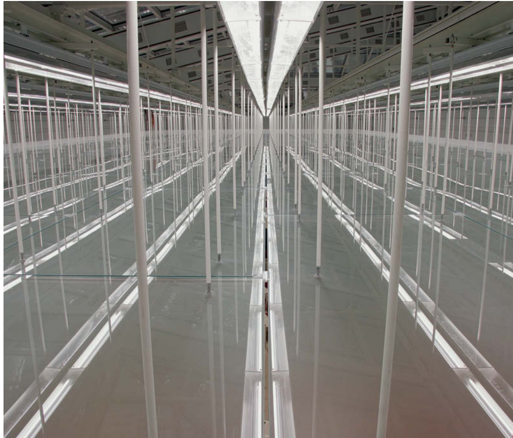
Deckenhohlraum, Draufsicht auf das Glas der Lichtdecke
