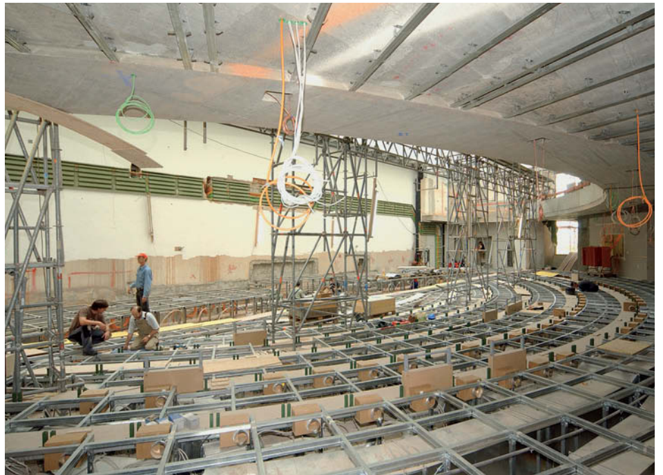
Einbau der Unterkonstruktion für das ansteigendeG estühl
