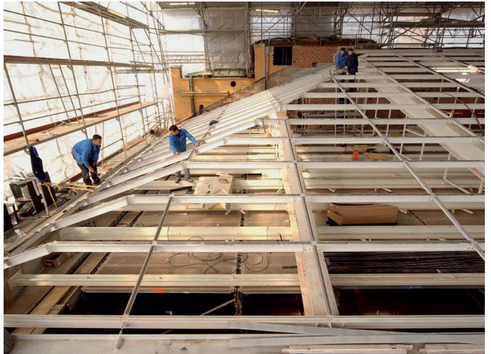
Neue Glasdachkonstruktion für mehr Tageslicht im Saal
