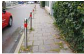
Engstelle von knapp 1 m Breite mit Leitpfosten sowie Bewuchs und Querneigung von 3 %
