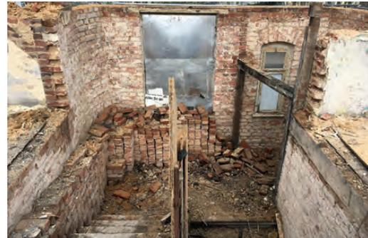
optimale Verzahnung der Recyclingziegel (Abmessung, Bauphysik) mit Bestand
