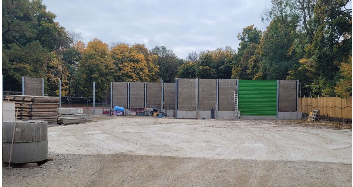
RS7 - Montage Paneelen Lärmschutzwand
