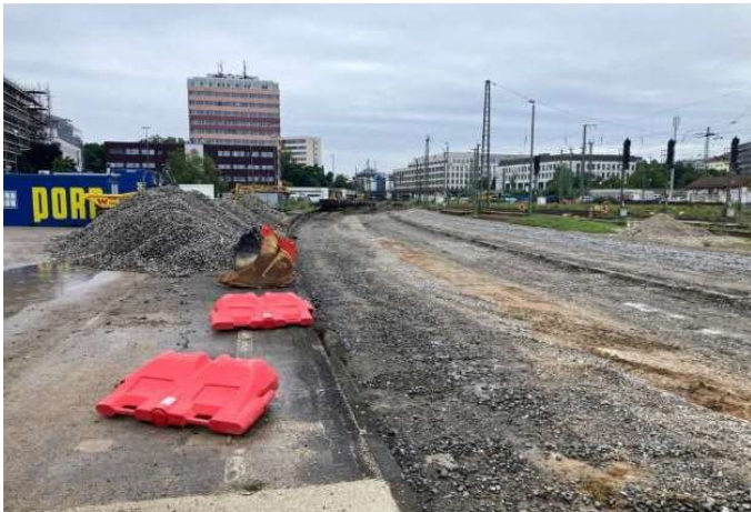
Rückbau Gleise Autoreisezuganlage
