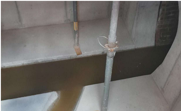
MSE-Kanal - Provisorium in Betrieb genommen
