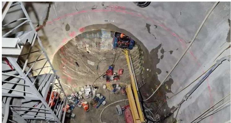
Blick in Richtung unterer Schacht/ Einfahrkaverne West vor Auffüllung
