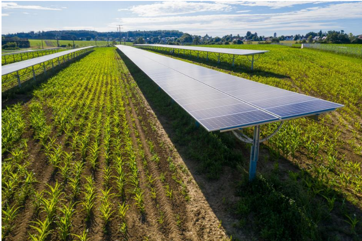
Abbildung 13: Nachgeführte Agri-PV-Anlage in Althegnenberg (Foto: Thomas Rebitzer)
