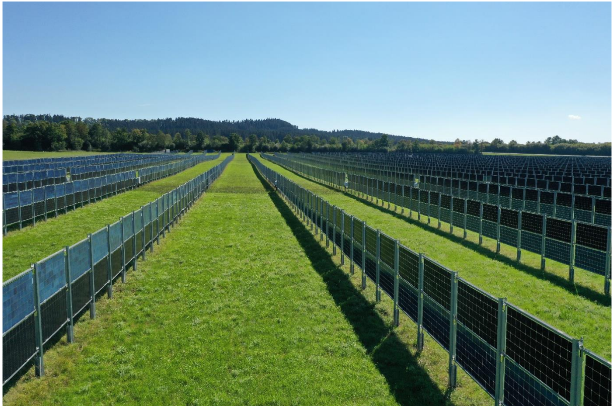
Abbildung 14: Vertikal aufgeständerte Agri-PV-Anlage in Donaueschingen-Aasen (Foto: Johannes Scharf, TFZ, 09.09.2020)
