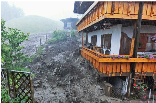
Starke Erosion beim Murereignis am 14.06.2015 (Roßbichlbach / Oberstdorf)
