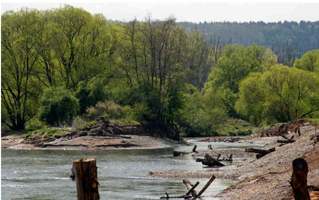
Mainverlegung bei Ebing im Zusammenhang mit Infrastrukturmaßnahmen: der Aushub wird für die neue ICE-Trasse verwendet.
