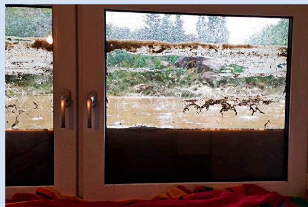
Hochwasser an einem Kellerfenster
