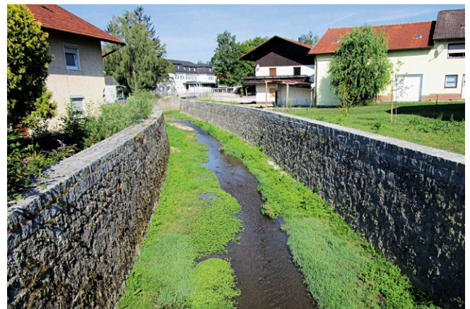
Bachbett und Ufersicherungen vor der Umsetzung der Maßnahmen
