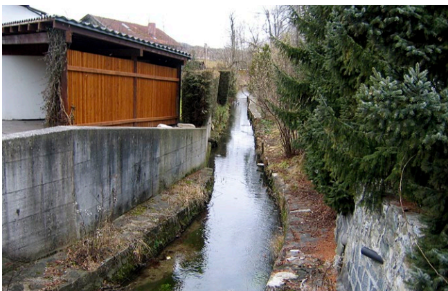
Unzureichender ökologischer Gewässerzustand: Durch Verbauung stark beeinträchtigte Gewässerstruktur, Aubach im Landkreis Starnberg
