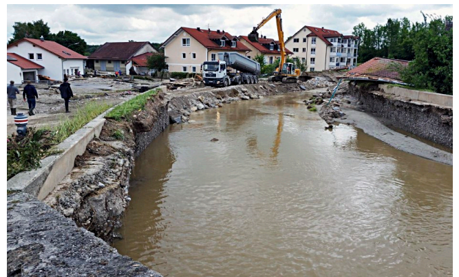
Wiederaufbau und Instandsetzung
