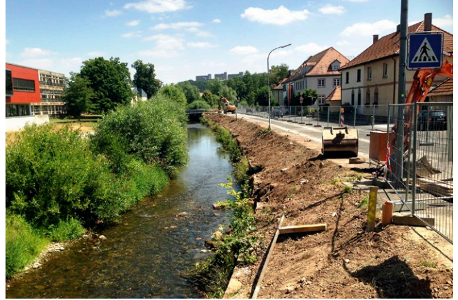
Baumaßnahme am Wildbach Brend im Bereich der Otto-Hahn-Straße zu Beginn der Ausführung
