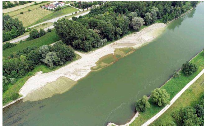
Geschüttete Kiesbank schafft Kieslaichplätze (Donau bei Dünzing)
