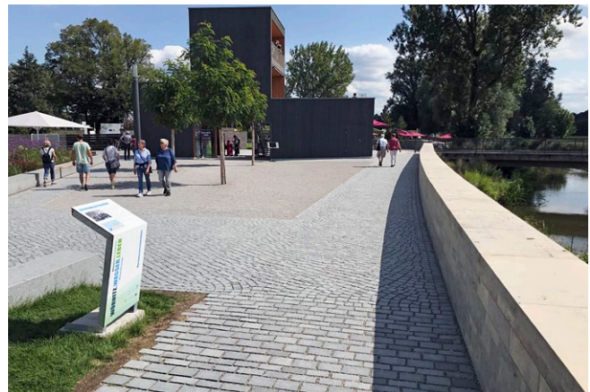
Im Zuge der Gartenschau errichtete Hochwasserschutzwand
