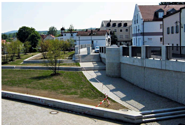
Terrassenanlage vor der fertigen HWS-Wand
