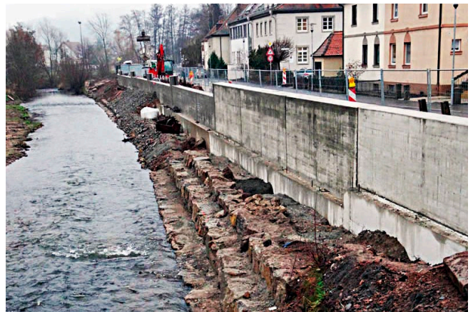
Fertiggestellte Hochwasserschutzwand, Blick von der Hohen Brücke
