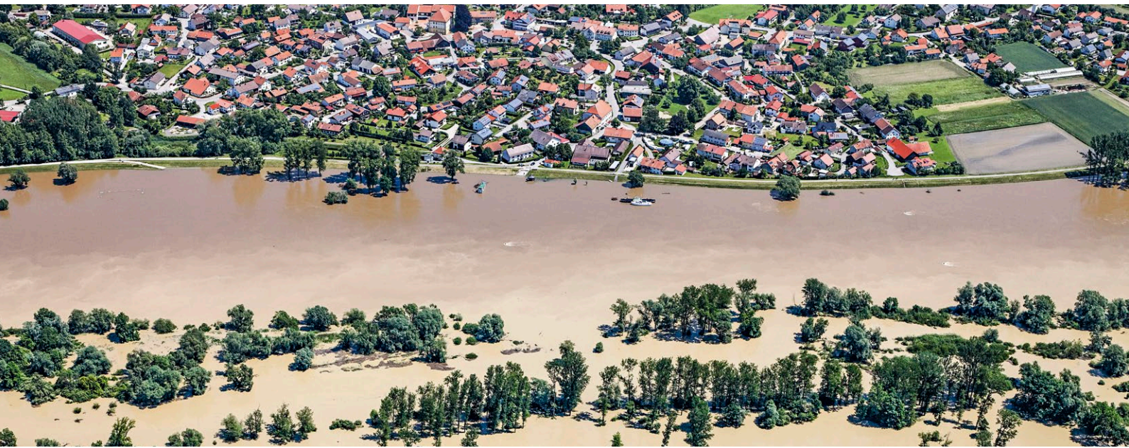
Hochwasser in Niederaltach 2010 (Donau)
