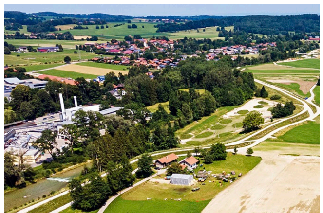
HRB Feldolling, Deichrückverlegung im Bereich des Zulaufgerinnes
