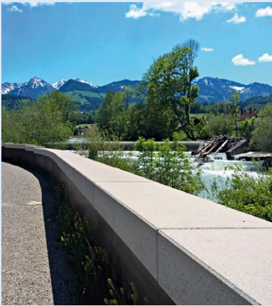
Schutz – technischer Hochwasserschutz: Hochwasserschutzwand bei Kempten
