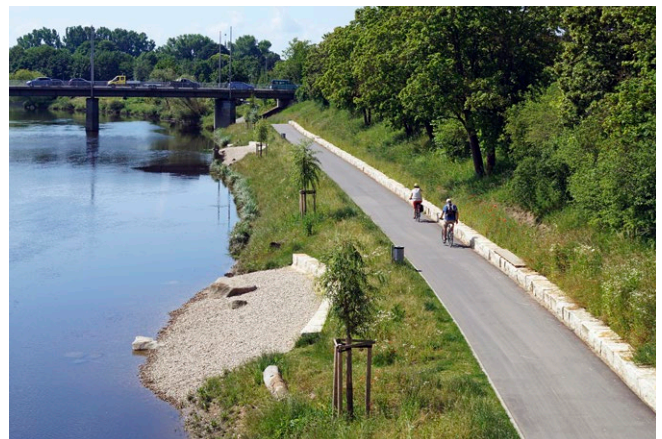
Neuer Geh- und Radweg und neue Gewässerzugänge
