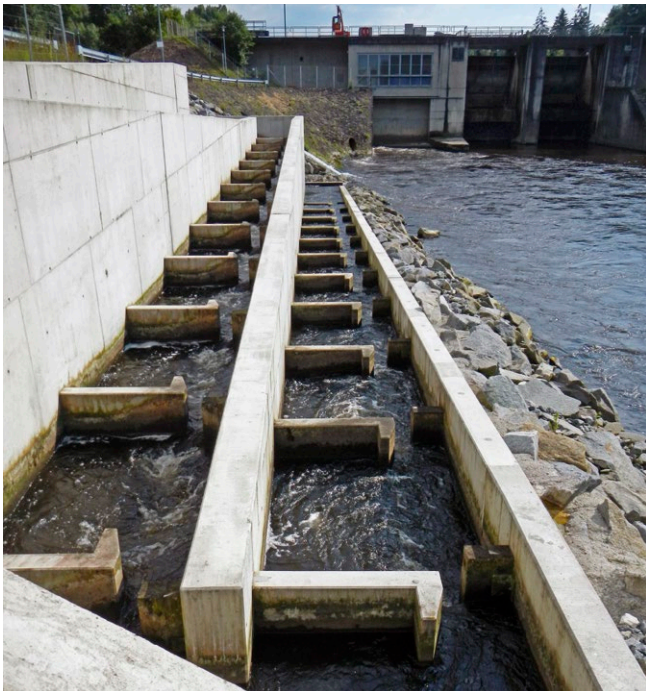
Technische Fischaufstiegsanlage (Schlitzpass)
