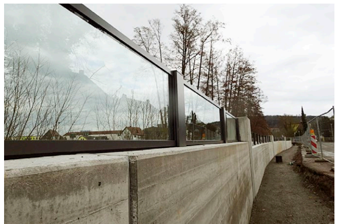
Fertiggestellte Hochwasserschutzwand mit Glasaufsatz, Nähe Rampe (Jahr 2014)
