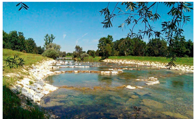
Umbau eines Absturzes in eine Sohlgleite (Mangfall bei Bruckmühl)
