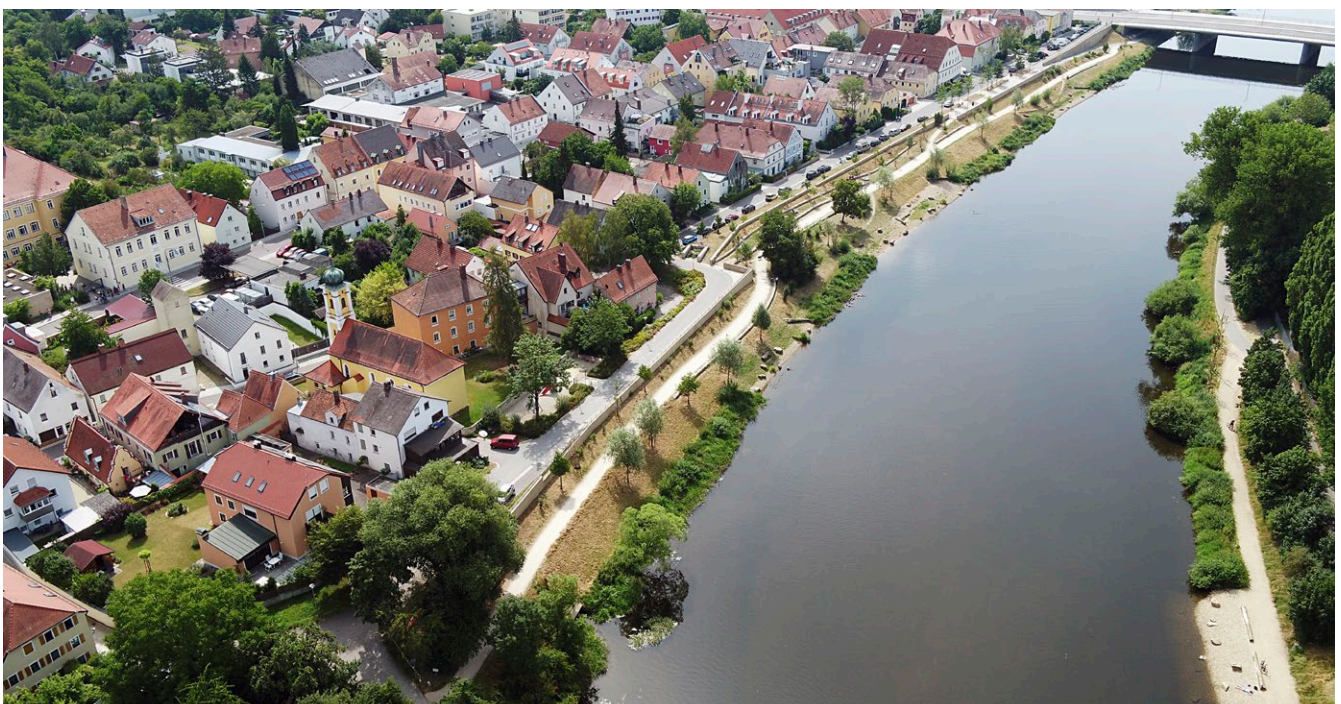
Fertiggestellte Maßnahmen am Regen in Reinhausen
