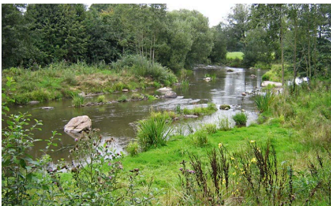
Störsteine und Leitwerke (Schwarzach in der Oberpfalz)
