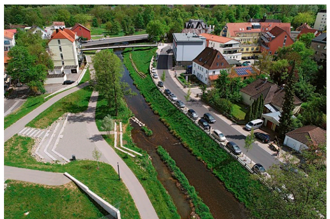
Fertiggestellte Hochwasserschutzwand mit Glasaufsatz, Nähe Rampe (Jahr 2014)
